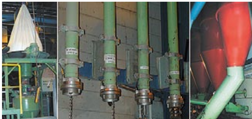
Figura 2.8. Transportadores neumáticos para materia prima en polvo [237, HUT, 2003]
