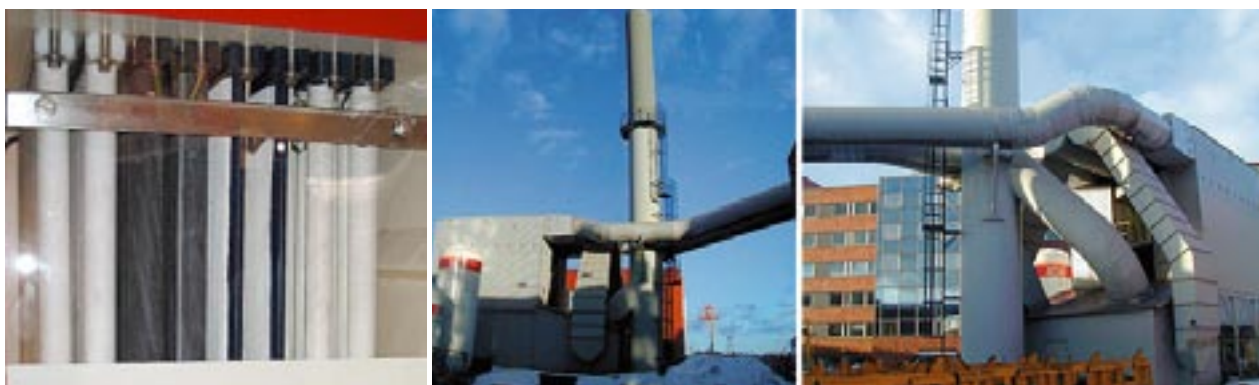
Figura 4.10. Unidades de filtro de mangas; parte interior (izq.) y exterior (centro, der.) [237, HUT, 2003]
